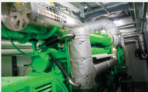
Fig. 8: WKK in akoestische omkasting.
