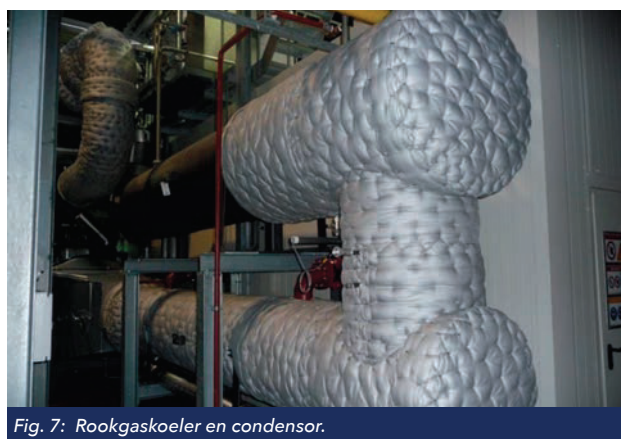
Fig. 6: Rookgaskoeler en condensor na stoomketel.
