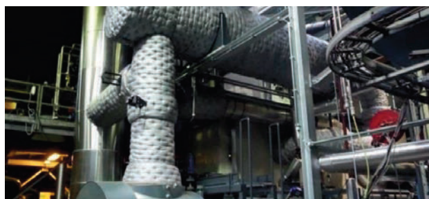
Fig. 5: Recuperatiestoomketel naast de WKK-omkasting.
