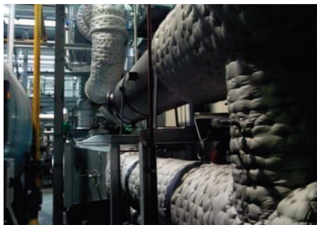
Fig. 6: Rookgaskoeler en condensor na stoomketel.
